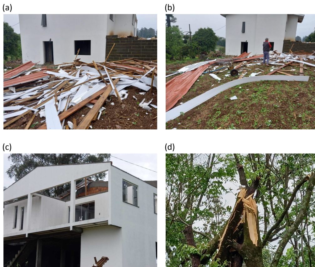
Figura 4 - Imagens dos danos causados pela super célula tornádica no município de Guatambu na noite do dia 13 de setembro de 2021. Fonte: Peter Scheuer/ND
